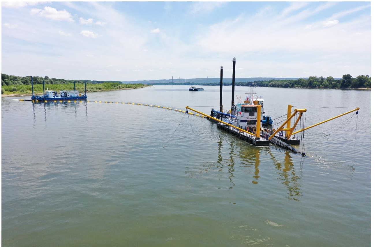
Драгажни работи в района на о-в Белене
